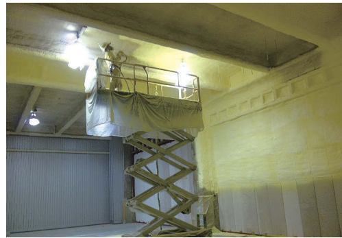
天井・壁：アキレスエアロン-R施工
